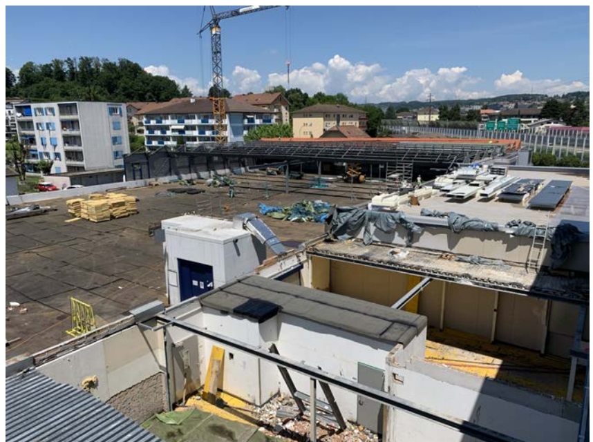
↑ Chantier du centre de distribution de Galaxis à Lausanne-Ecublens
